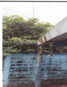
Foto 6: sustitución de canales de metal a pvc
