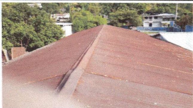
Foto 3: sustitución de capote de lámina troquelada
