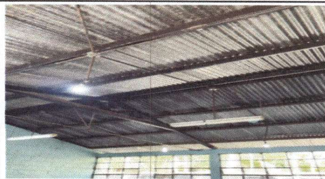
Foto 4: Mantenimiento de estructura de soporte de metal.
